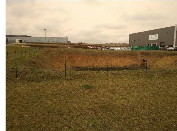
Figure 26 : Bassin d'infiltration présent sur la parcelle voisine au projet.
